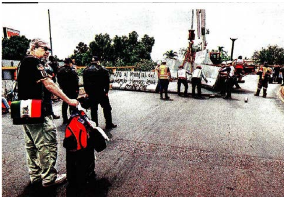
Colocación de dovelas en los alrededores de la terminal. CUARTOSCURO
