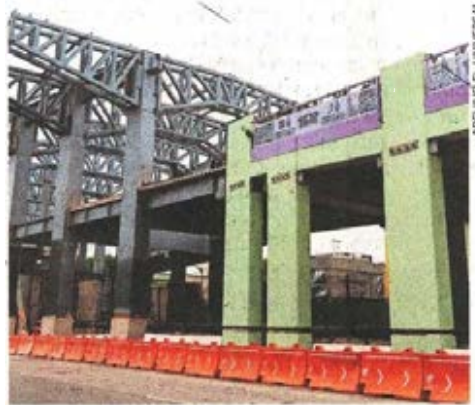
En el Parque Elevado aún falta por concluir el tramo hacia el Metro Chabacano.
