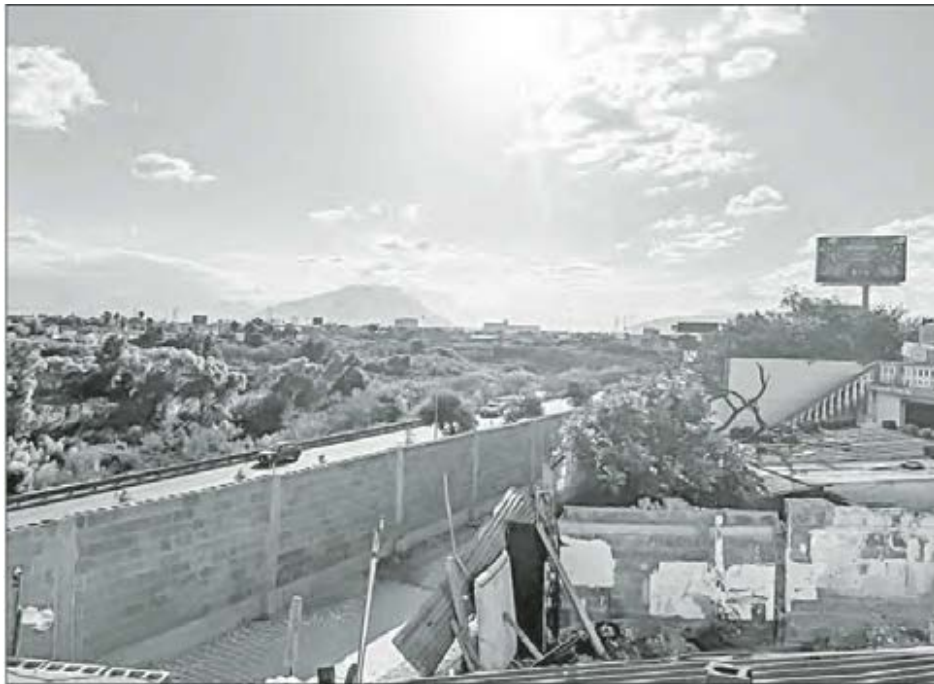
Uno de los muros construidos para "tapar" sectores humildes y comercios populares por "no ser convenientes para los turistas". La imagen, en el bulevar Miguel de la Madrid, municipio de Guadalupe, Nuevo León. Foto Vianney Carrera
